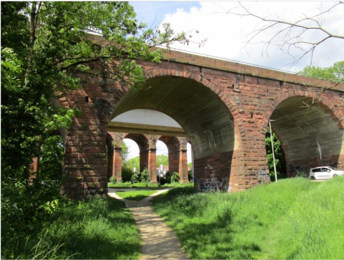
Rosental-Viadukt Friedberg · Foto: Carin Utermöhle
